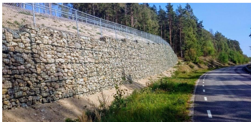
Figur 12: Krossad betong i permanent anläggningsprojekt (bild från PEAB).
